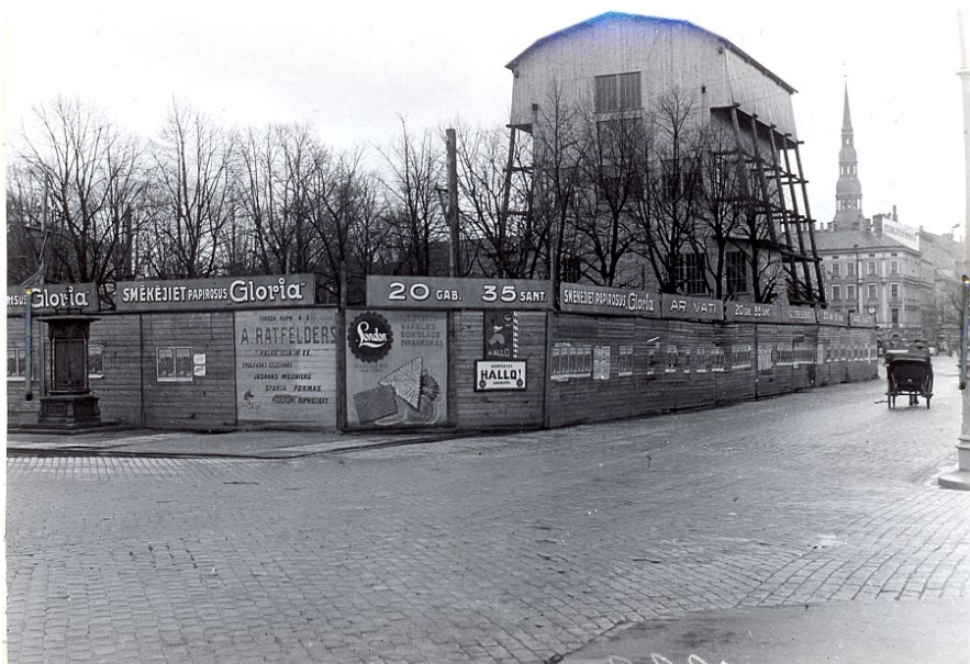
Brīvības pieminēkļa būvniecības laikā 1930. gadā
